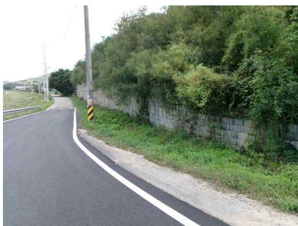
5공구 블럭식 옹벽 06
