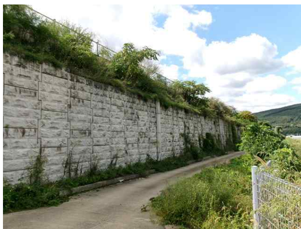
6공구 패널식 옹벽 08
