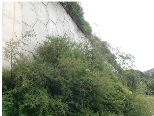
3공구 패널식 옹벽 01
