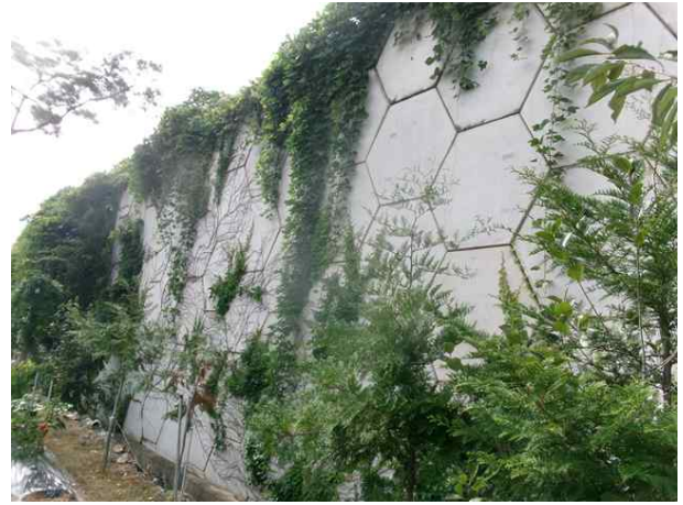
8공구 패널식 옹벽 14
