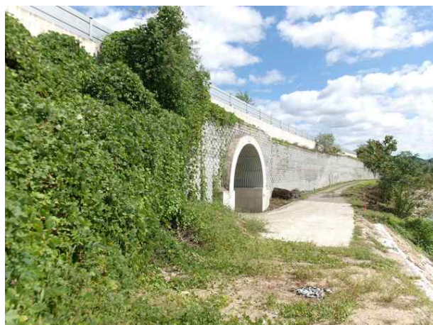
6공구 블럭식 옹벽 09
