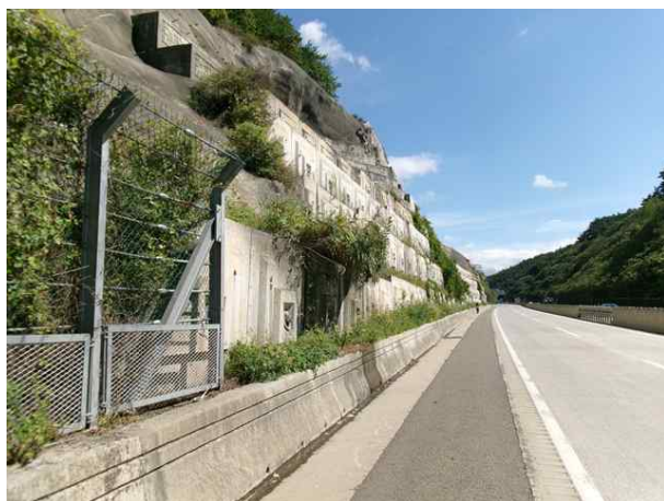
6공구 패널식 옹벽 10
