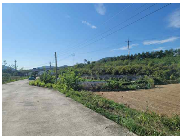
3공구 블럭식 옹벽 03
