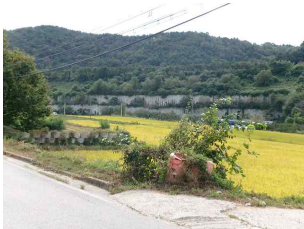
3공구 패널식 옹벽 02
