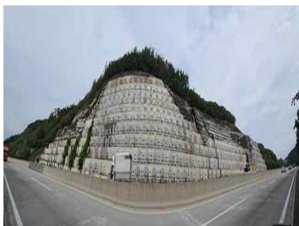
4공구 패널식 옹벽 05
