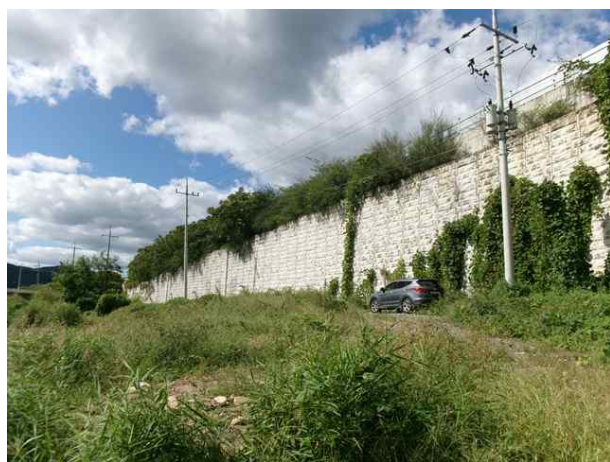
6공구 패널식 옹벽 07
