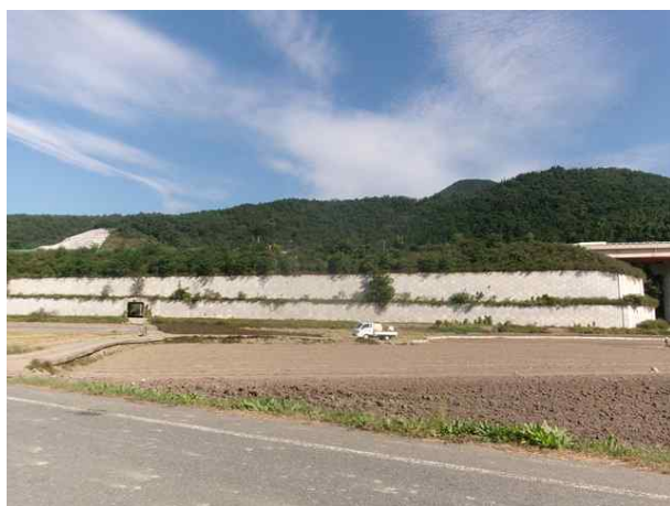
7공구 패널식 옹벽 12
