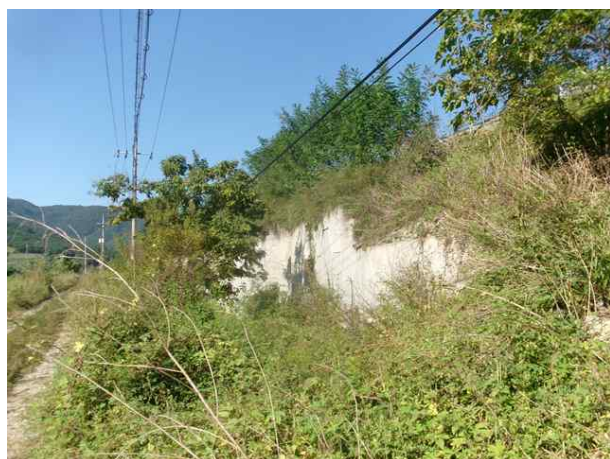
7공구 패널식 옹벽 11
