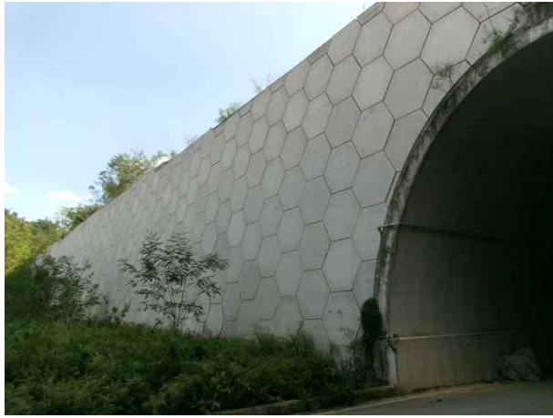
8공구 패널식 옹벽 13
