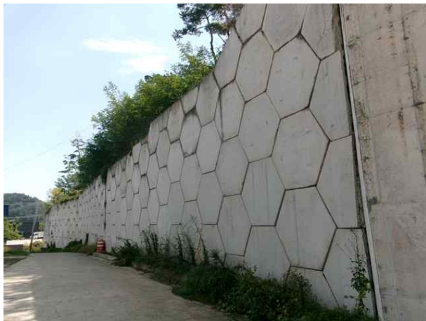
9공구 패널식 옹벽 15
